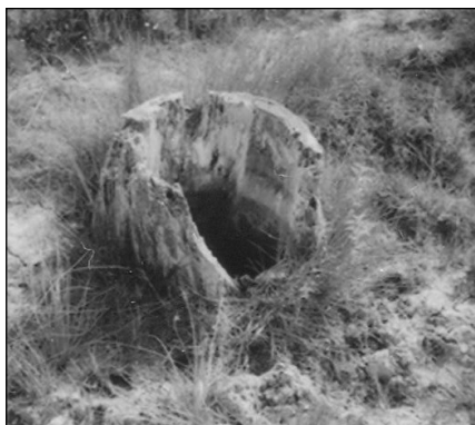
2. kép. Cementgyűrűs sós kút (Baszest - Basești, 2004)
